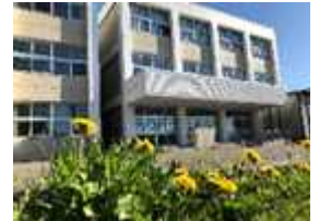
改修により外壁が新たに塗り直された校舎
